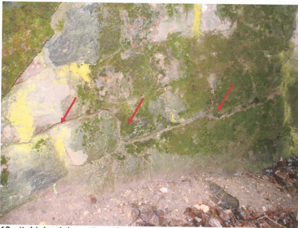
13.att. Liela plaisa mūra atbalstsienas spārniņā pie krasta balsta Nr.1 lejteces pusē.
