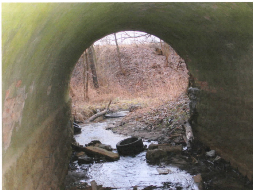
9.att. Skats no lejteces puses uz velvi no iekšpuses. Vietām cementa javas pārklājuma nodrupumi.
