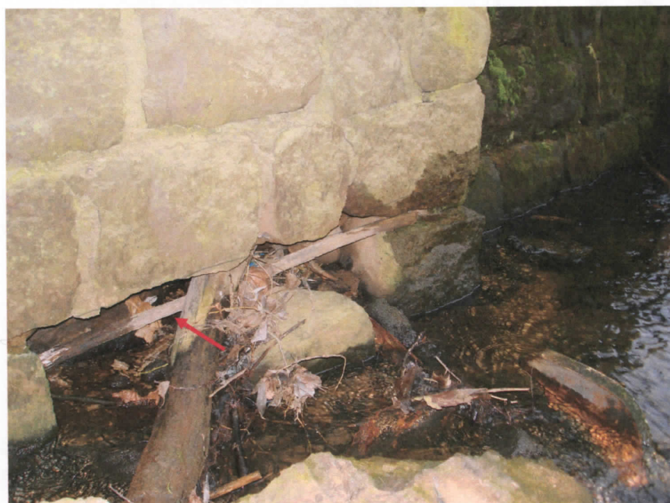
10.att. Paskalojums pie velves pamatiem augštecē pie
